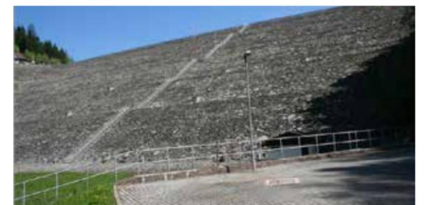
Низводна косина на каменонасипната брана Турчек, со берми за поставување на оскултационата опрема
